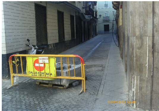
Imagen 2: Obras en calle del Casco Histórico
